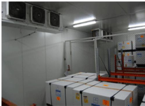
*Валидированная холодильная камера вместимостью до 180 паллет. Ежеминутный контроль температуры осуществляется пятью датчиками Sensatronics. Система предупреждения высылает sms- и e-mail-оповещения при наступлении критических событий. Система предупреждения дублируется звонком круглосуточно дежурящего оператора.*
